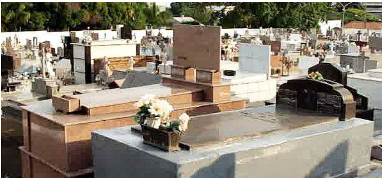
Figura 15 – Imagem Panorâmica parcial do Cemitério da Piedade, apresentando em primeiro plano dois túmulos horizontais de alvenaria revestidos em granito.
