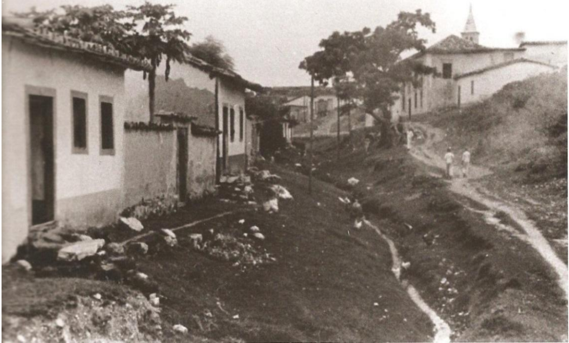
Figura3 - Reprodução de imagem do Córrego da Prainha, atual Avenida Tenente Coronel Duarte, em imagem de 1941. Fonte: SIQUEIRA, Elizabeth Madureira et al. Cuiabá - De vila à metrópole nascente . Cuiabá: Entrelinhas, 2006. p. 29.
